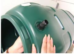
③雨水タンク本体に穴があり、本体の内側から筒が出るようにして、回しながら設置します。
