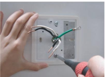
(1) 取付座中央の穴から屋内配線を通し、壁面または天井面および床面の補強材のある場所に、木ネジ(2本)で固定してください。
